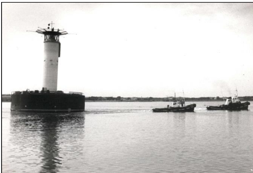
Læsø Rende Fyr blev bygget i Aalborg, og bugseres her af Goliaths slæbebåde ud gennem Limfjorden.
